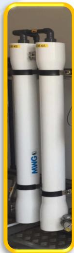
L'acqua filtrata e condizionata con i chemical specifici raggiunge in pressione l'aspirazione di una pompa ad alta pressione che sospinge il flusso controllato da manometri nelle due membrane ad osmosi inversa che generano la produzione di acqua pura la cui purezza è misurata nel pannello di controllo osmosi, da una sonda che ne legge durante l'esercizio, i valori
