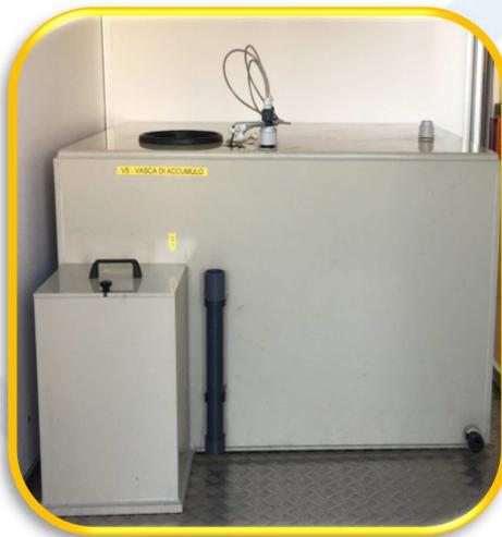
L'acqua osmotizzata (PERMEATO) viene inviata alla vasca di accumulo in polipropilene e anti-sciabordio con sensori di livello per rilevare allarmi di alto/basso livello o mancanza acqua osmotizzata
