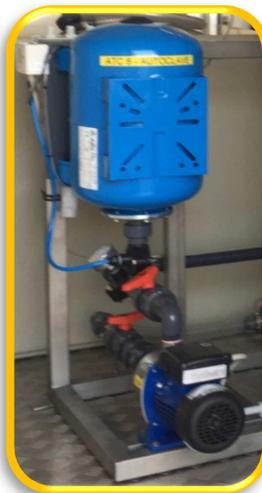
L'acqua osmotizzata accumulata deve essere inviata alla utenze tramite un gruppo di pressurizzazione automatica; per mantenere in pressione l'acqua è predisposta una pompa centrifuga orizzontale controllata da un pressostato per mantenere costante la pressione sulla linea di distribuzione
