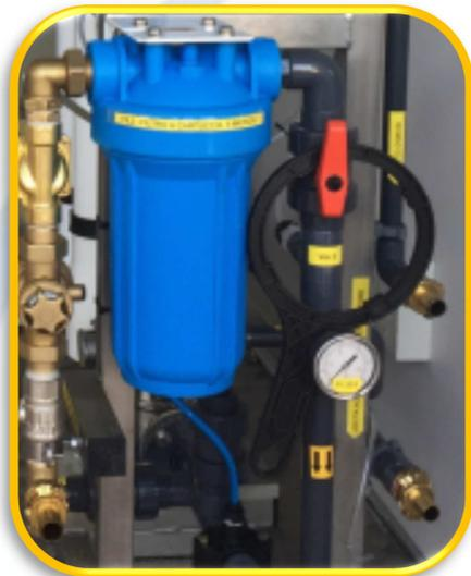
L'acqua grezza in alimento viene microfiltrata attraverso un filtro a cartucce avente grado di filtrazione 5 micron, prima di passare alla sezione di osmosi inversa allo scopo di proteggere dallo sporco, gli spaziatori delle membrana di osmosi
